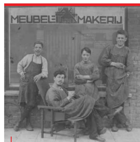
6 MEUBELWERKPLAATS RIETVELD GERRIT RIETVELD IN STOEL Rietveld Schröder Archief
